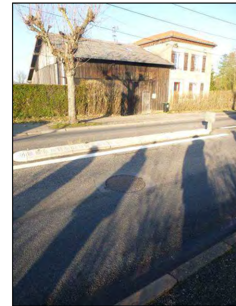
Tampon eaux usées existant sous la RD38
