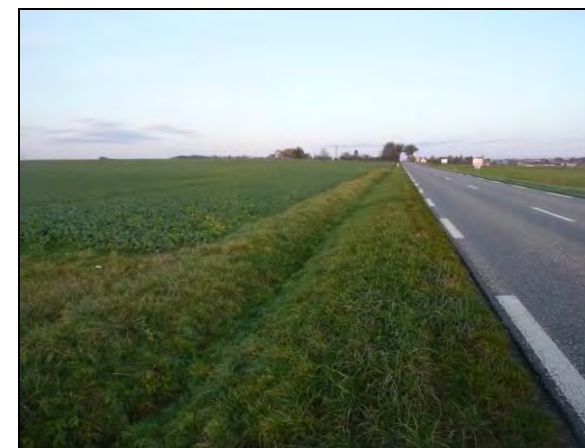
Fossé longeant la RD38, au point de rejet du projet de ZAC
