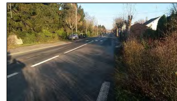
Tampon EU existant en tête de réseau sous la RD38
