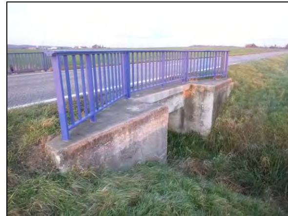
Ouvrage cadre sous la RD38 aval
