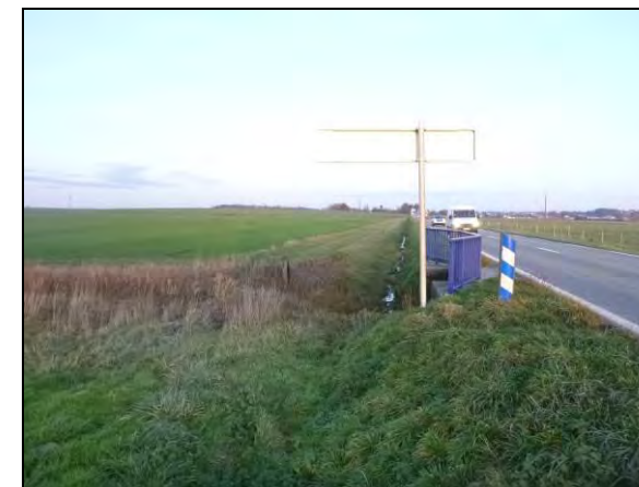
Fossé de la RD38 rejoignant l'ouvrage cadre sous la RD38
