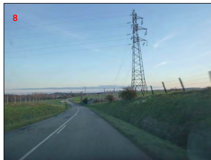
Vue sur la ZAC entre Val-de-Bride et Dieuze (poste électrique)
