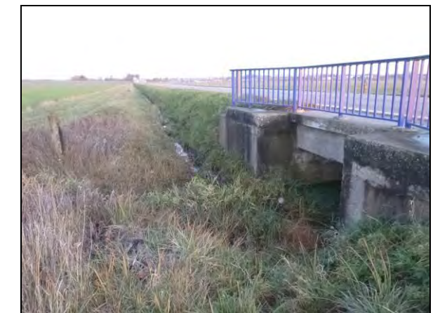
Ouvrage cadre sous la RD38 amont
