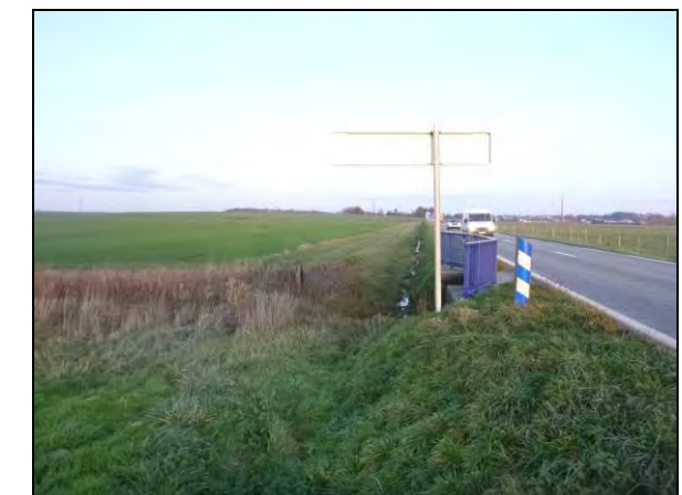
Le fossé rejoignant l'ouvrage cadre sous la RD38
