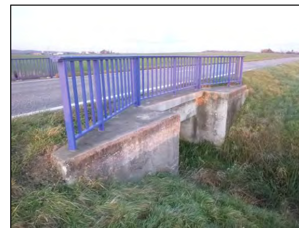
Ouvrage cadre sous la RD38 aval
